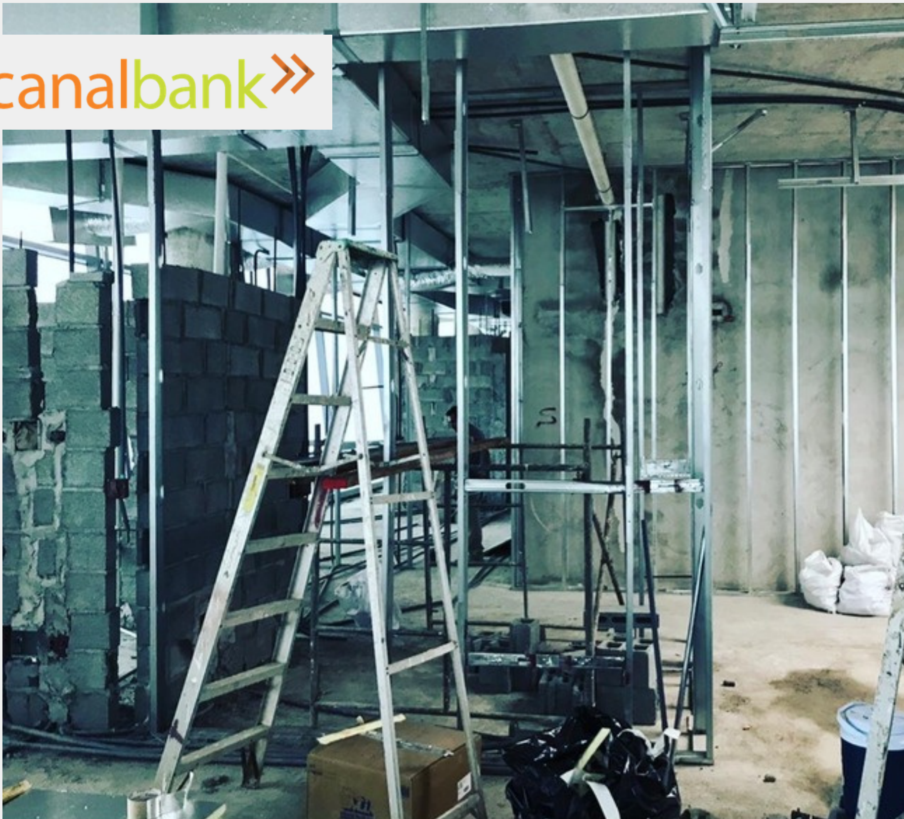
Construcción paredes de gypsum
