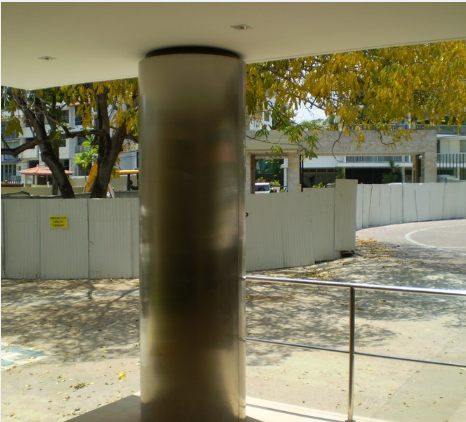
Revestimiento de columnas de acero inoxidable
