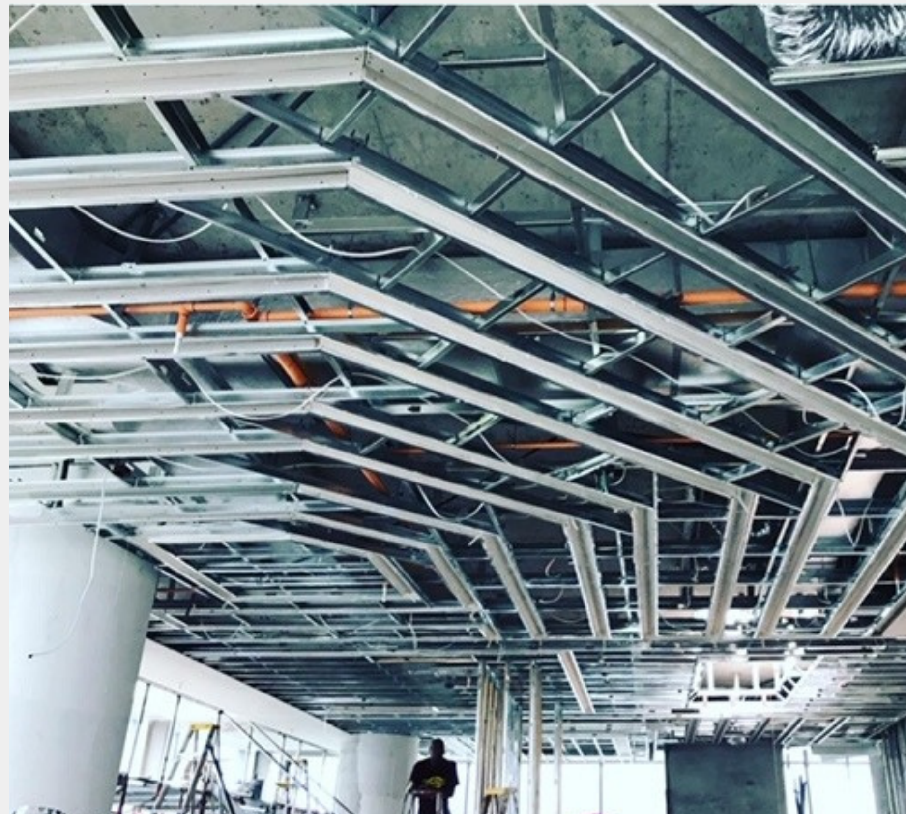
Construcción de cielo raso de gypsum
