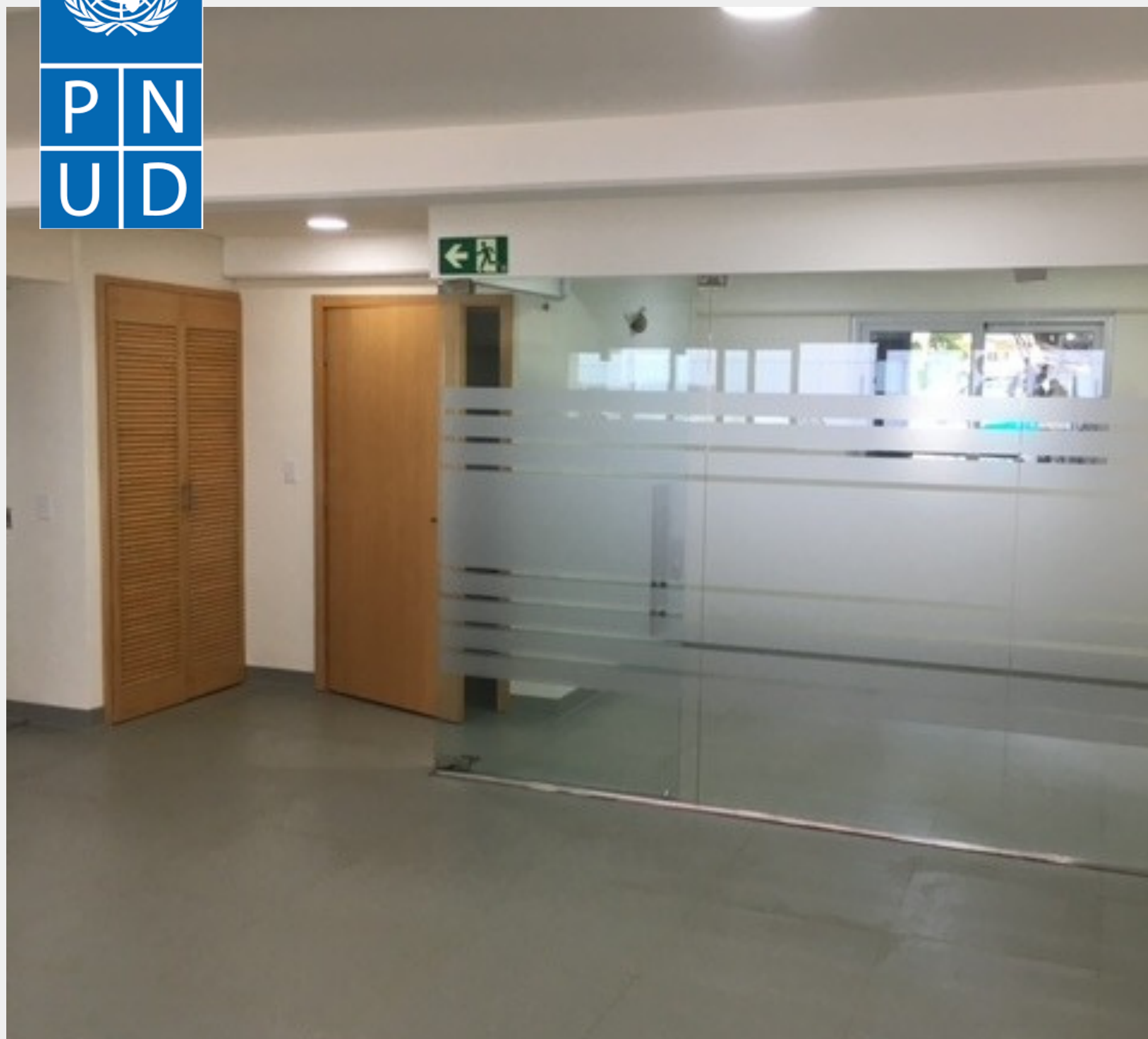
Suministración e instalación de vidrio templado Puertas tipo persianas de madera y piso técnico.
