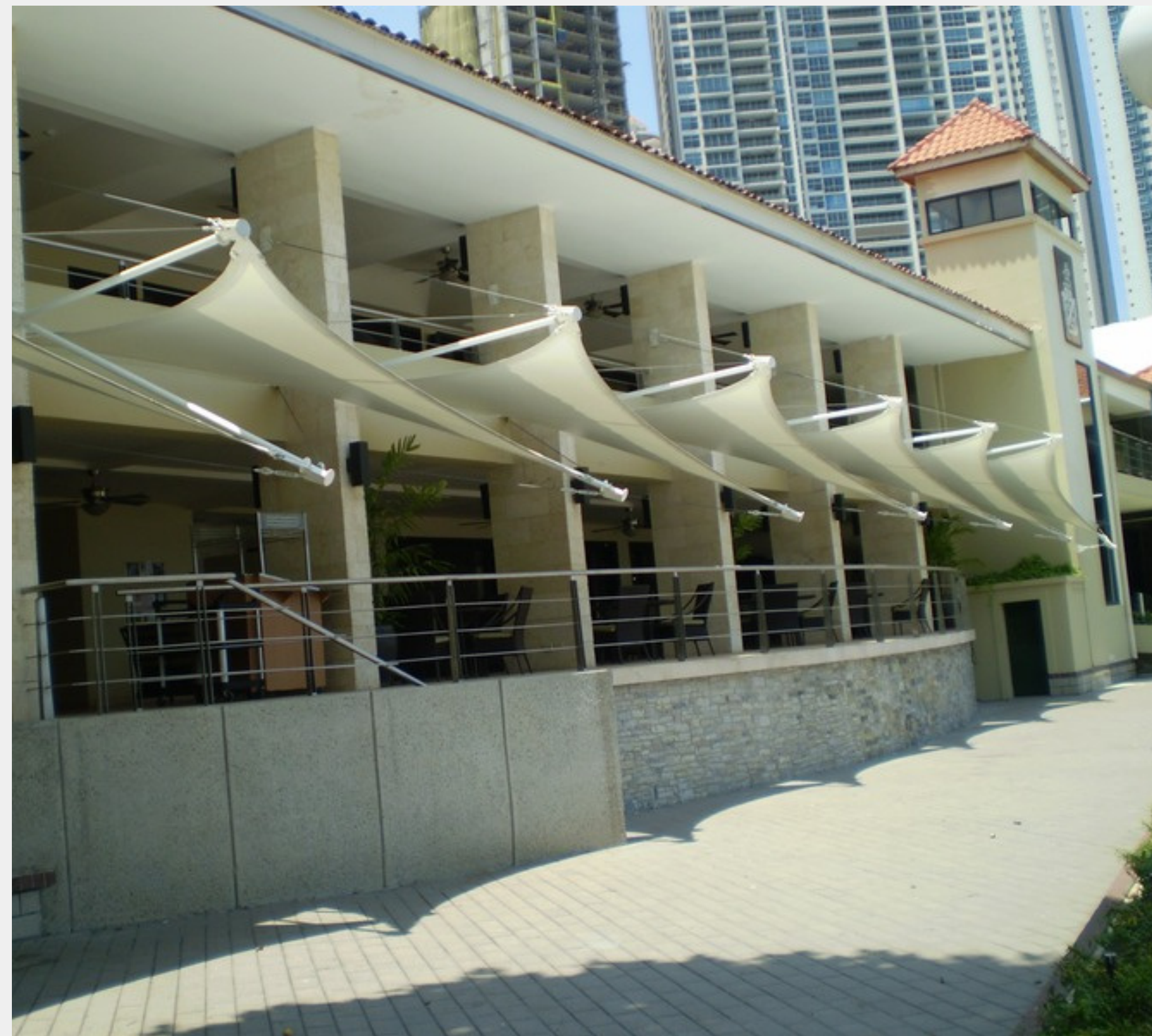
Suministración e instalación de toldas
