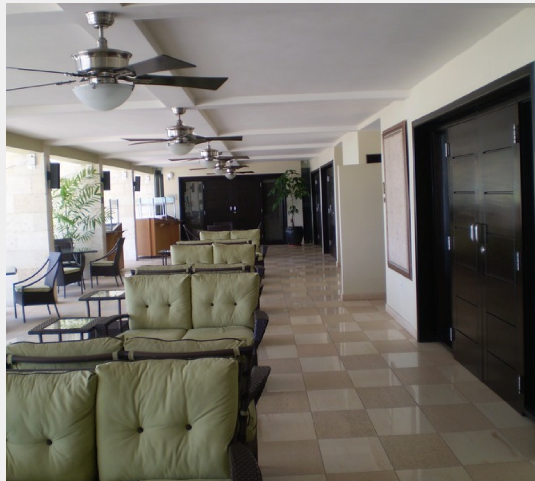
Revestimiento de piso en porcelanato Construcción de cielo raso de gypsum
