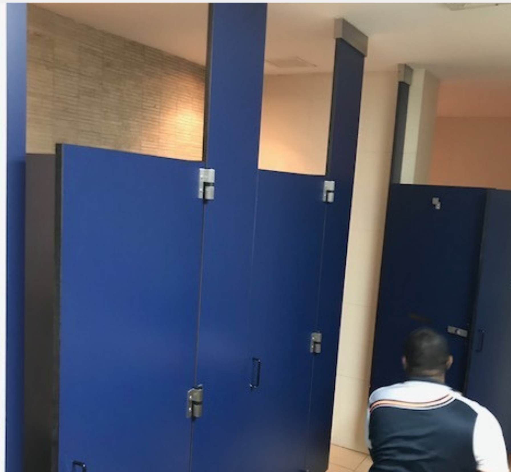
Instalación de particiones de baño
