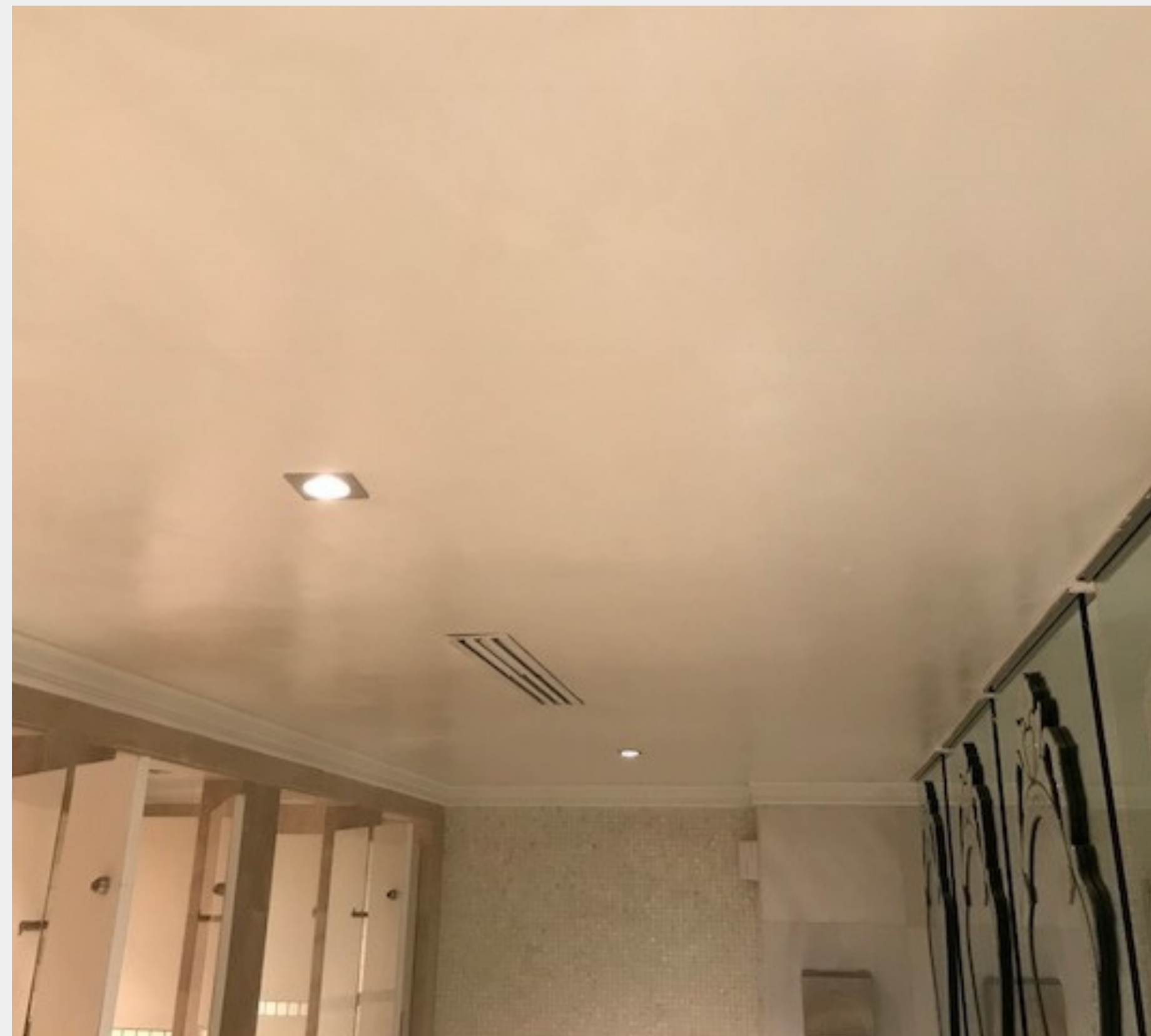
Cielo raso de PVC en baños
